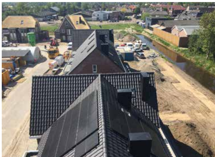
Gecombineerd met zonnepanelen
